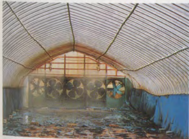
超高速回転ノズル(エバシステム)による 尿汚水気化処理装置
