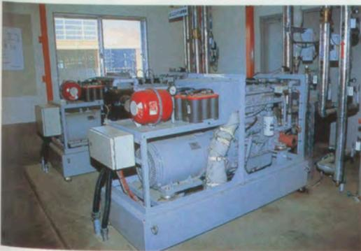
乳牛糞尿循環研究センター：ガス発電装置
