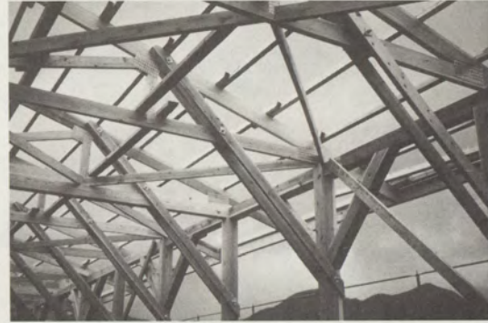
写真2 白石市牛舎ネイルプレート接合
