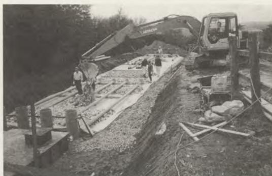
写真2 有孔トレンチの設置とカキ殻敷き込みの状況
