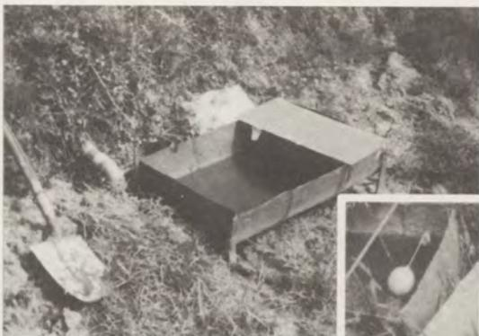
図10 止水弁付飲水器に変えて泥浄化を防ぎ乾田化した
