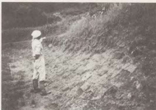
図8 法面に牛糞（接着力が強い）を利用してシバ苗を貼り付けた
