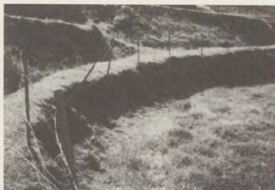
図6 牧柵を法面の法縁に設置したために牛によって崩され裸地化した
