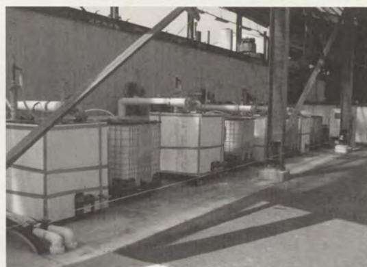
写真2 既存の堆肥化施設に対応した複数台のスクラバー（畜産草地研究所）
