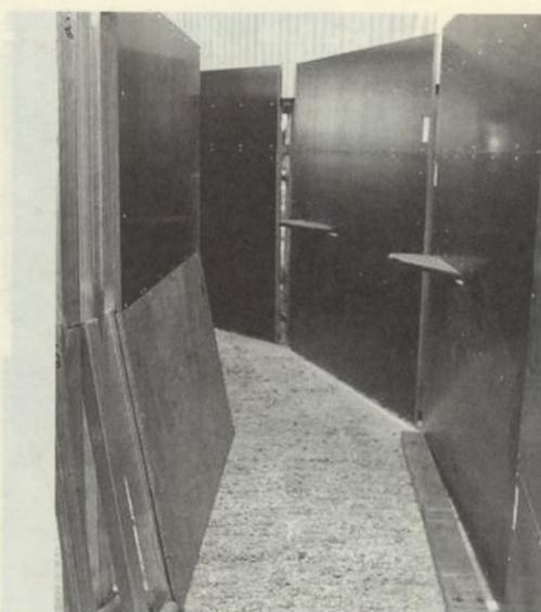
写真11 逆流防止策を施した通路
